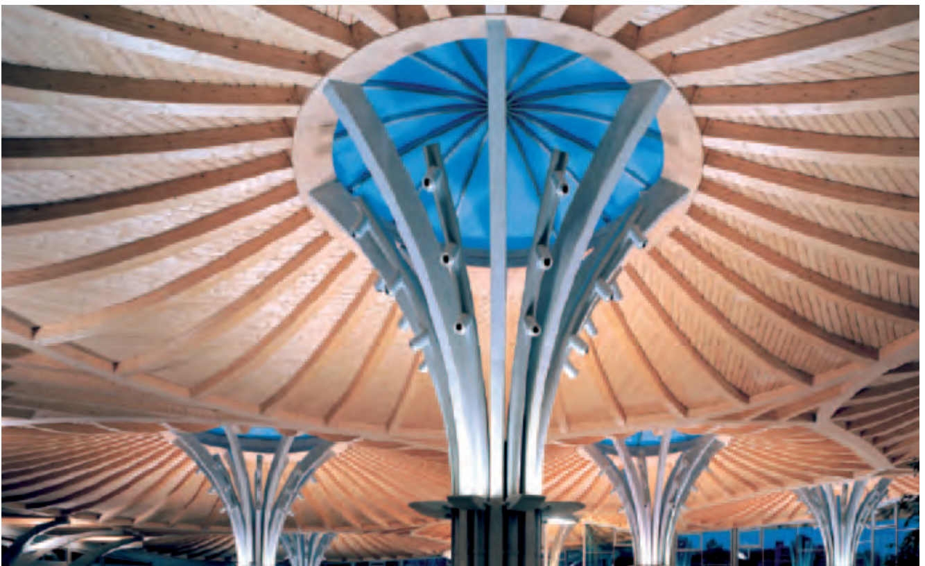
Ingenieurholzbau am Beispiel einer besonderen Dachkonstruktion (Elefantenhaus des Kölner Zoos)
